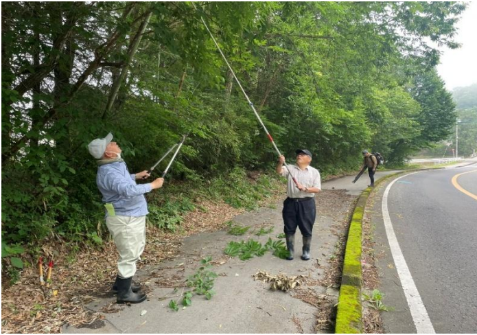
作業状況①
