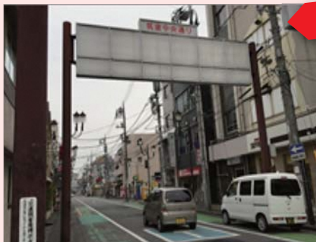
撤去されずに残されたアーチ看板
