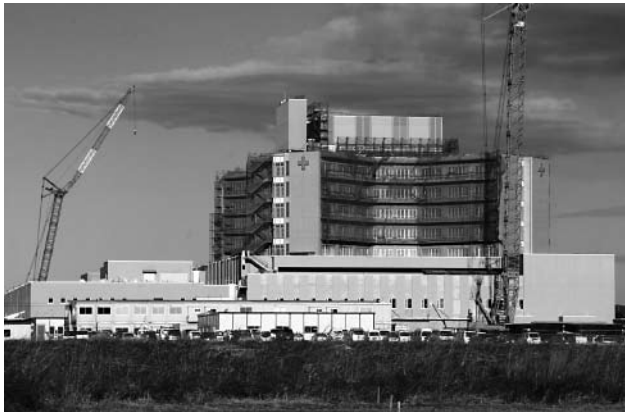
建築中の那須赤十字病院(2月8日撮影)
