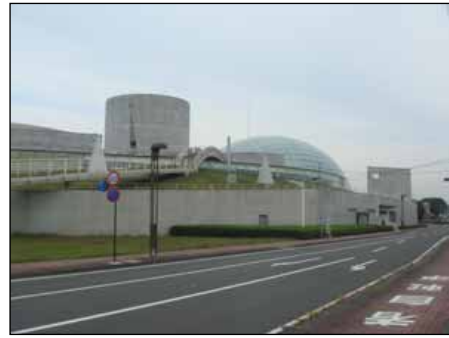
《那須野が原ハーモニーホール》
