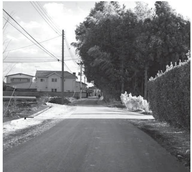
認定外道路の舗装等を進めています
