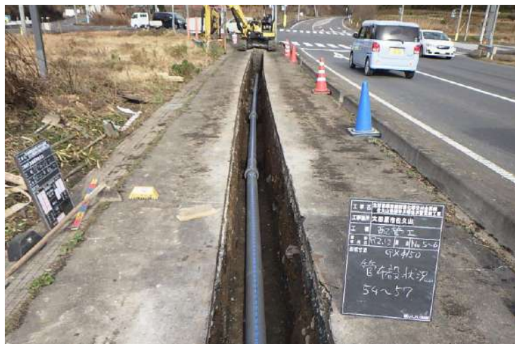
送水管の耐震化
