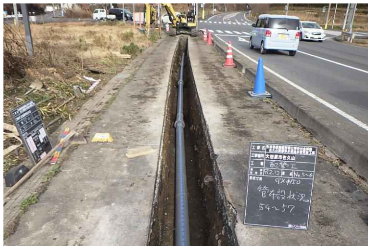
送水管の耐震化
